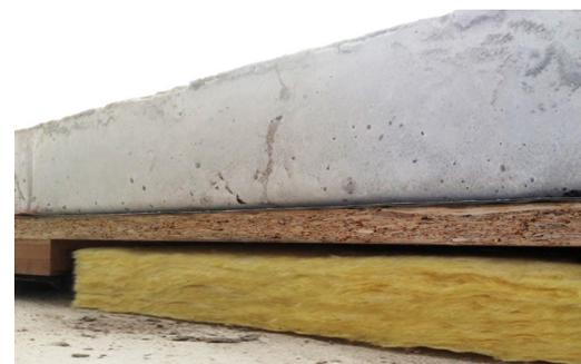
Dalle flottante et coffrage perdu sur plots anti-vibratiles.
